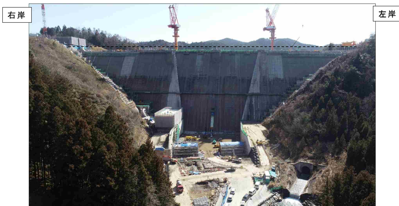
ダム下流より堤体を望む
