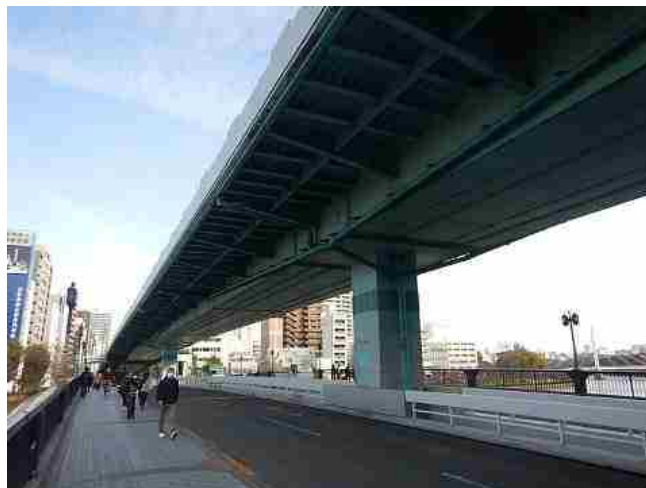
橋梁上のルート
