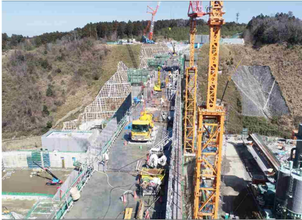
ダム左岸より堤体を望む
