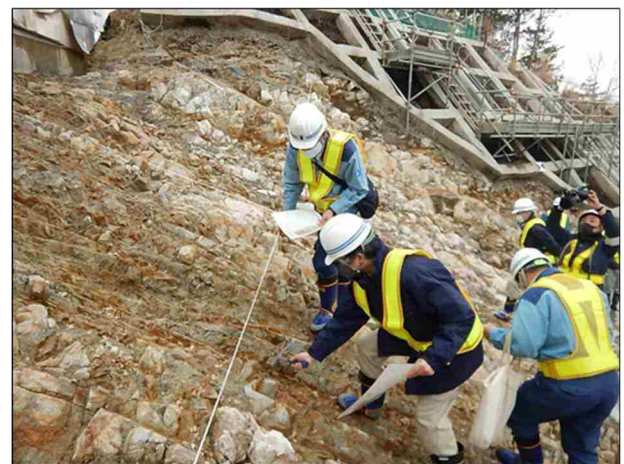
検査員による岩盤確認状況
